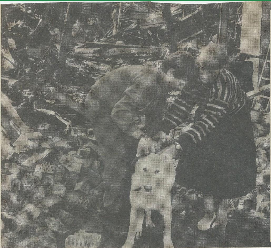
Solveig Petersen og sønnen Jesper kigger på resterne efter millionbranden, der har skabt store problemer. Silberbauer forsøgte at beredde hammerne med en brandslange (Foto: Olav B. Hansen)
